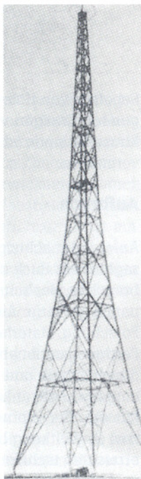
Bild 3: Funkturm in Mühlacker, 1933/34 von der Siemens Bauunion GmbH gebaut. Höhe: 190 m. Zerstört 1945. (aus: „bauen mit holz“ 8/1992)
