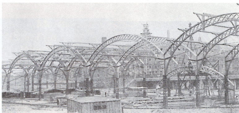
Bild 2: Bahnsteighallen des Hauptbahnhofs in Kopenhagen von 1912. Die hölzernen Binder sind hier auf eiserne Stützen aufgesetzt und überdecken in sechs Schiffen und zwei kleinen Seitenbauten die etwas über 130 m breite Halle (aus: Freitragende Holzbauten, C. Kersten, Springer Verlag, Berlin 1921)
