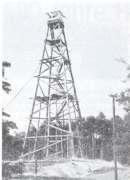
Bild 6: Auch kriegswichtig: Feuerwachturm, 32 m hoch, Rundholz mit Bolzen, Stahllaschen, Geka-Dübel, Baujahr 1941 (aus: „Der Bau von Feuerwehrtürmen aus Rundholz“, P. Zimmermann, Wilhelm Ernst & Sohn, Berlin, 1944)
